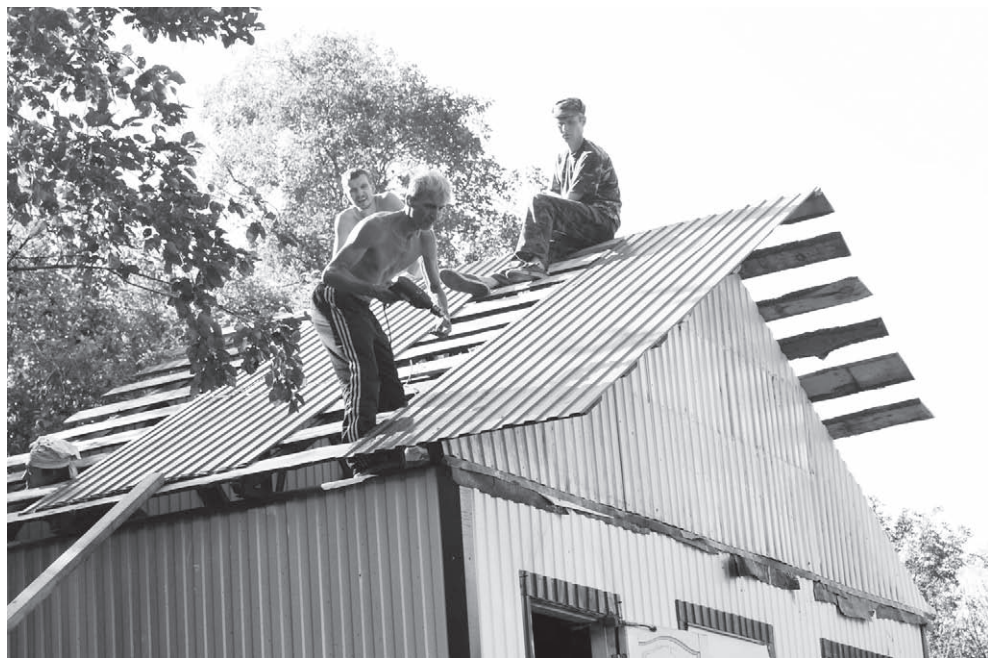
Строительство общего дома в экопоселении «Природное». 2012 г.
